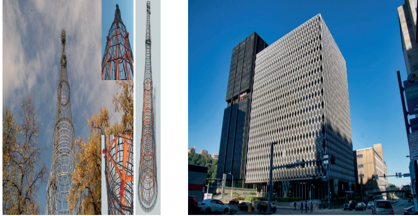
Resim 1. Shukhov Tower (Solda), (Travush ve diğ., 2018), IBM Binası (Sağda)
